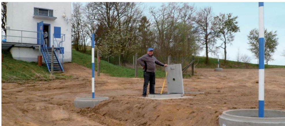
Stavba před kolaudací v dubnu
