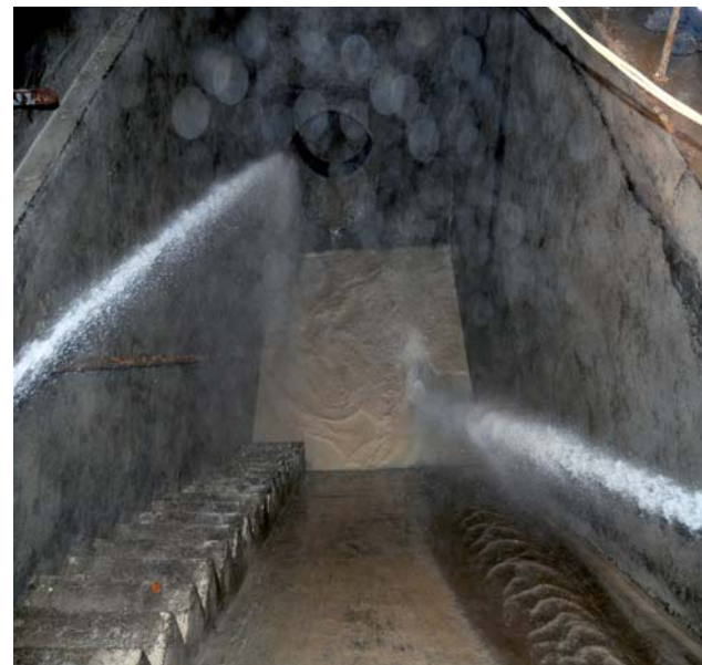
Čištění odtokové jímky akumulace
