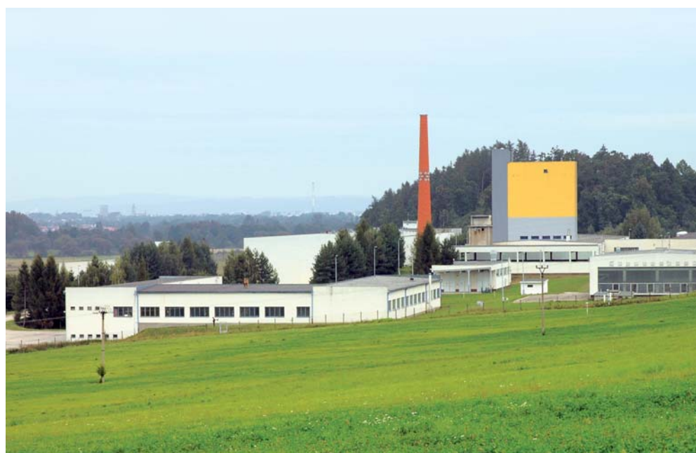
Úpravna vody Plav
