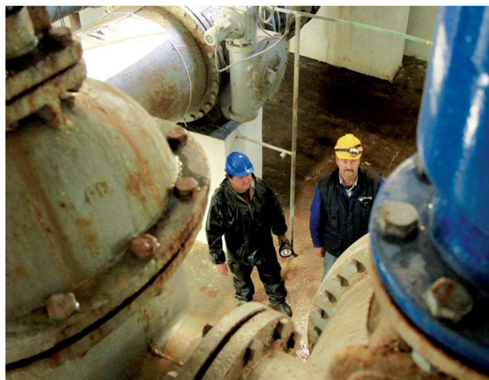
Vodárenský tunel ze 70. let je stále v dobrém technickém stavu
