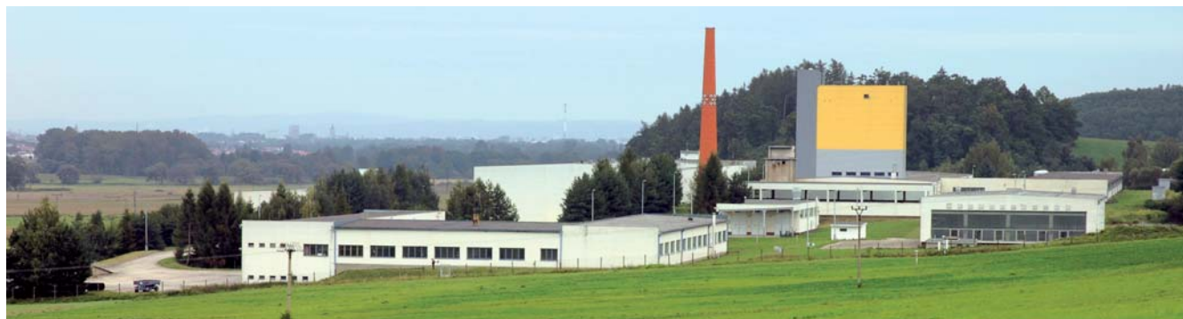
Z této „továrny na pitnou vodu“ v Plavu u Českých Budějovic se zásobuje na 380 tisíc obyvatel Jihočeského kraje.
