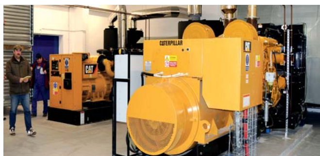
O výrobu „nouzové“ elektřiny se v případě potřeby postarají dva naftové agregáty - jeden vysokonapěťový s výkonem 1,25 MW a druhý nízkonapěťový s výkonem 0,56 MW. O jejich pravidelné testování se stará Zdeněk Pekárek.
