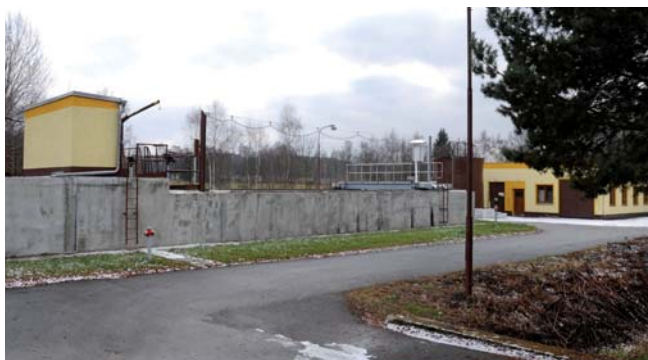
Město Kardašova Řečice investovalo do modernizace čistítky odpadních vod (na snímku), prodloužení vodovodu do místní části Nirtovice a rekonstrukci kanalizační sítě na 50 milionů korun
