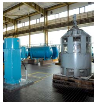
Úpravna vody Plav
