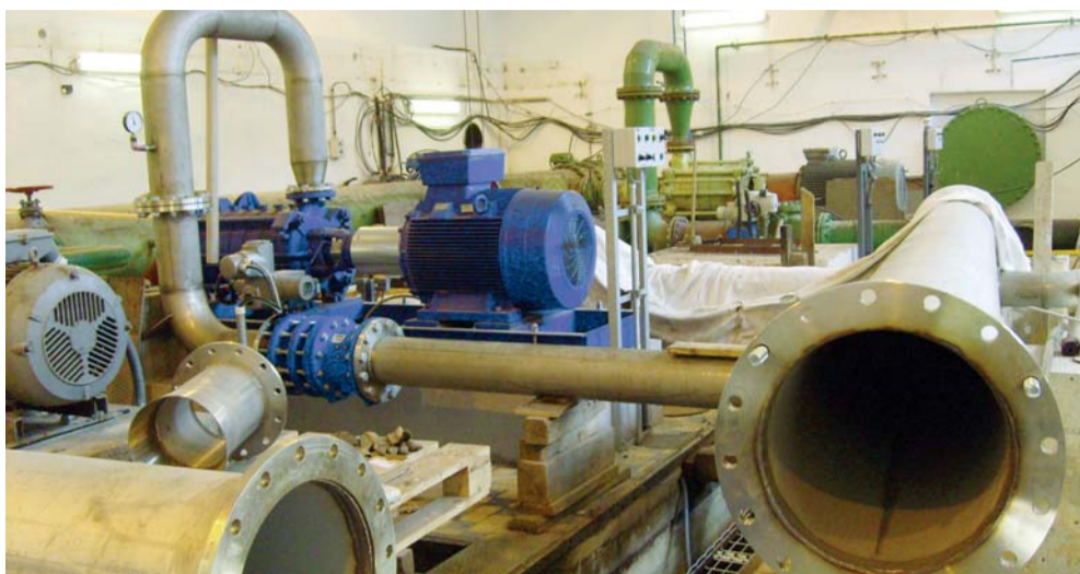
Čerpací stanice Těšovice
