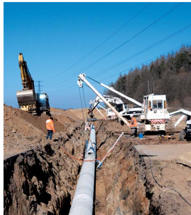
Práce pod vypnutým vysokým napětím.
