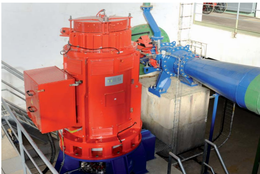
Nový generátor malé vodní elektrárny se synchronním uzávěrem.
