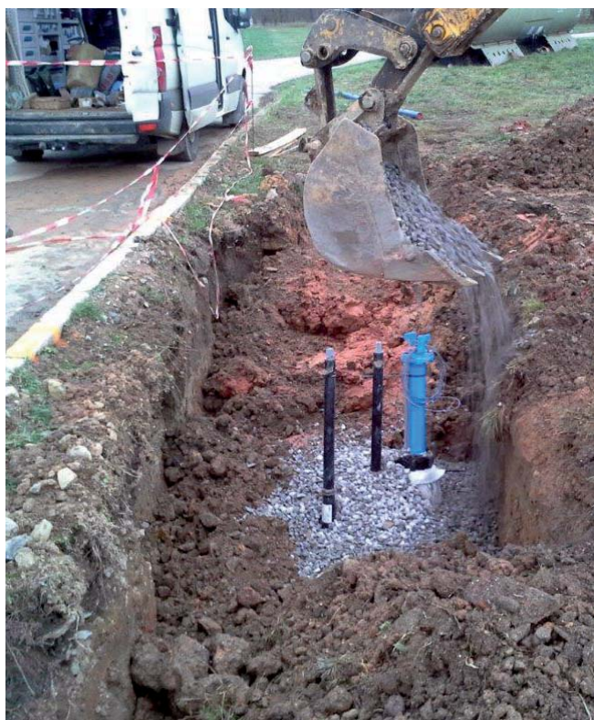
Propojovací armatury nového řadu vodárenské soustavy na síť obce Malovice.
