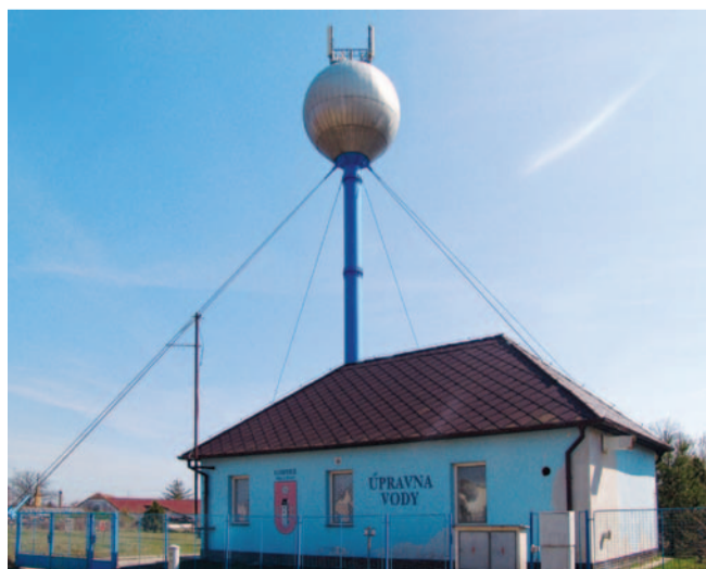
Lomnická úpravná vody a vodojem čekají na nový zdroj.
