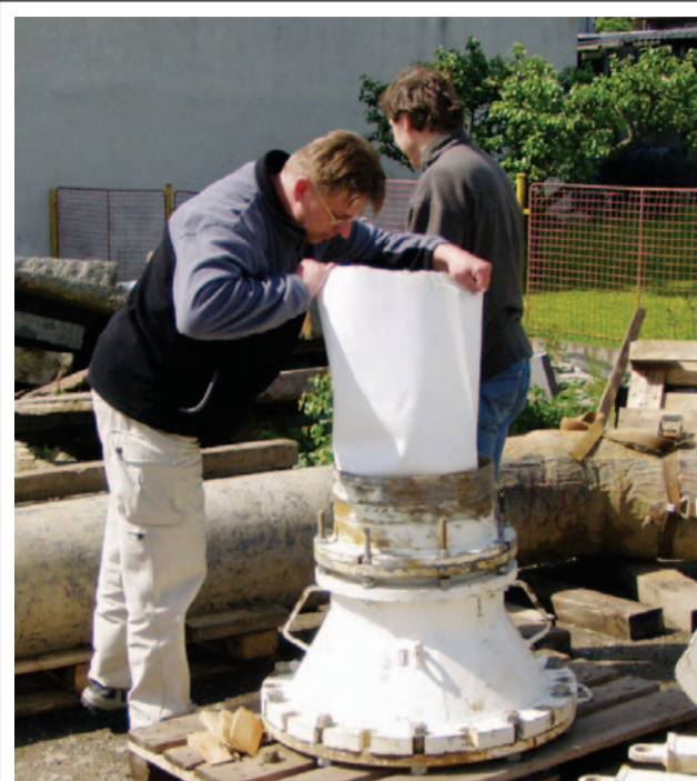
Jaroslav Gazda z JVS kontroluje laminátový rukávec pro sanaci vodovodu.
